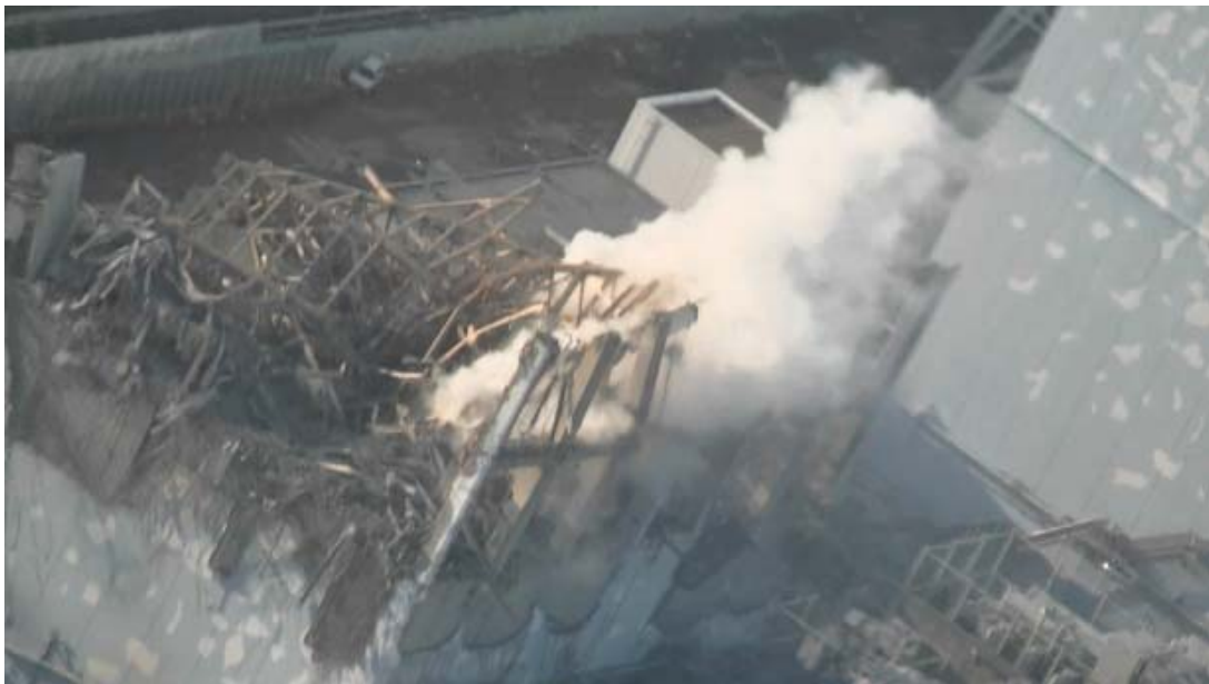
写真2. 2. 4-1 182 （水素爆発後、白煙を上げる3号機）
